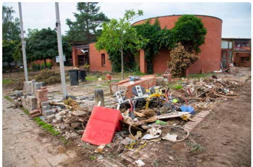
Die von der Flutkatastrophe zerstörte Kita Blandine-Merten-Haus. Die Betreuung erfolgt momentan in einem Provisorium, während die bestehende Kita abgerissen und neu aufgebaut wird. Foto: Gunnar A. Pier / Westfälische Nachrichten
